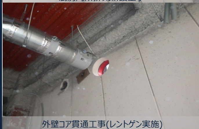
厨房局所排気新設工事
