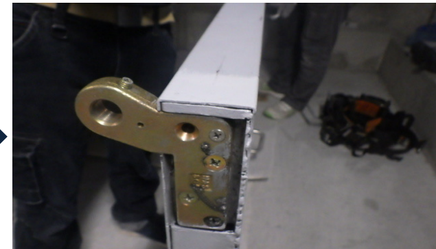
【ドアヒンジ修繕 施工後】
