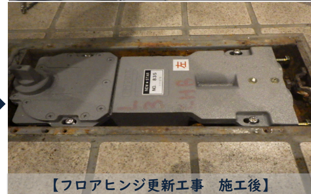
【ドアヒンジ修繕 施工後】
