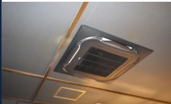
天井カセット型4方向 室内機
