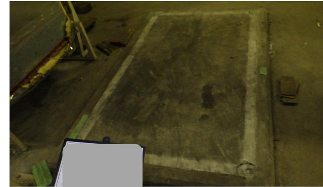
【送風機更新工事 既設撤去】
